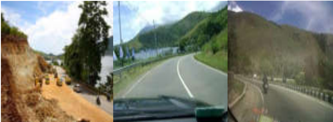
Gambar 9. Kondisi Eksisting Jalan Menuju Danau Sentani
